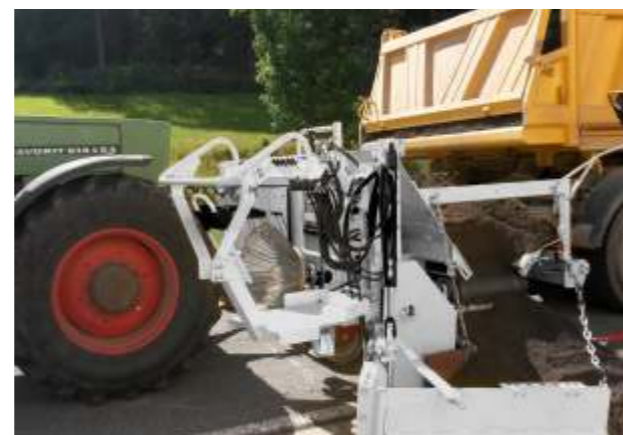
Kraftvoller Materialfluss bei der Bauausführung.
