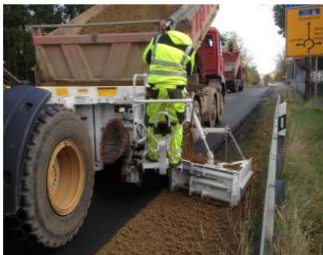
Sehr gute Gesamtübersicht beim Einbau.
