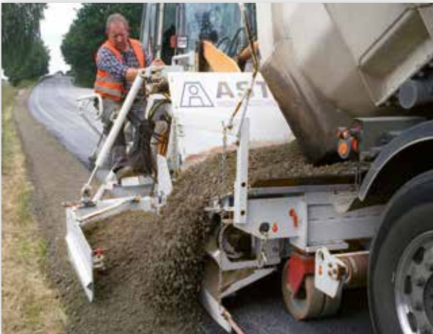
Schneller Niveauegleich mit Fahrbahnerneuerung
