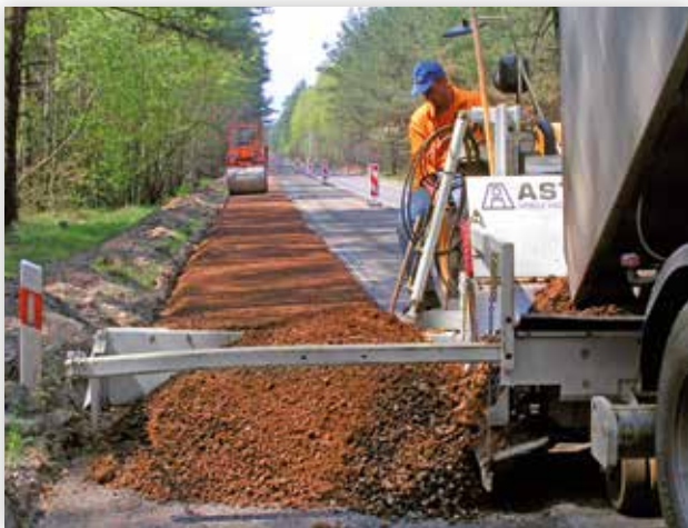
Banketteinbau mit 2 m Arbeitsbreite. Einbauleistung mit bis zu 400 t/Std. möglich
