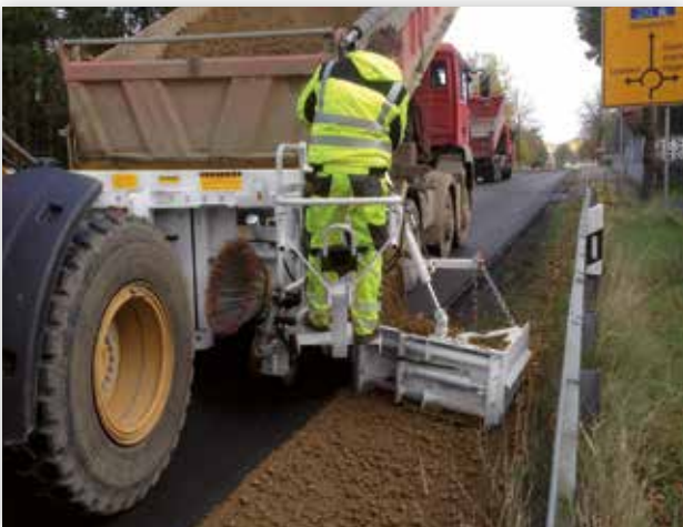
Sehr gute Gesamtübersicht beim Einbau
