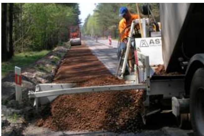
Banketteinbau mit 2m Arbeitsbreite. Einbauleistung mit bis zu 400t/Std. möglich.
