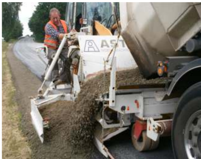
Schneller Niveaueausgleich nach Fahrbahnerneuerung.
