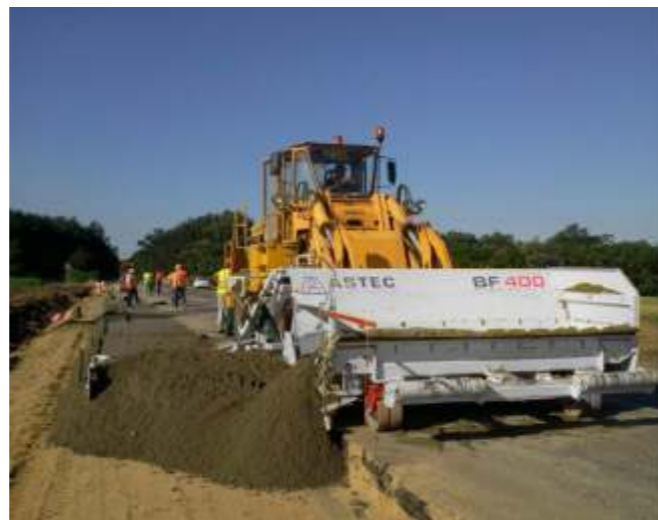
Fahrbahnverbreiterung mit 2m Arbeitsbreite.
